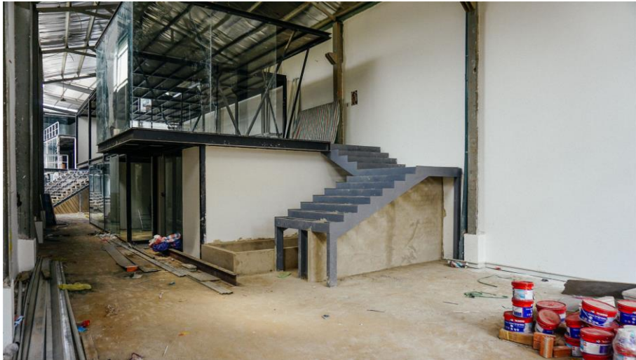
Hình 1.2 Hiện trạng xây dựng công trình
